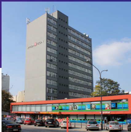
Budynek biurowo-usługowy Prometeon, Łódź 308 kW
